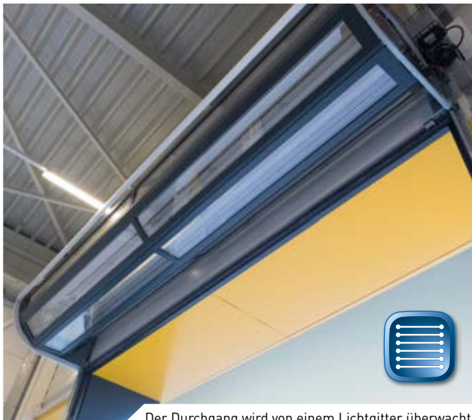
Der Durchgang wird von einem Lichtgitter überwacht
