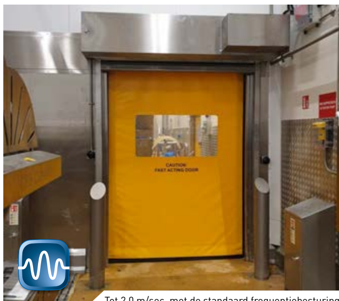
Tot 2,0 m/sec. met de standaard frequentiebesturing
